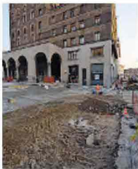
Alcune immagini dei lavori della metro in Piazza Vittoria
